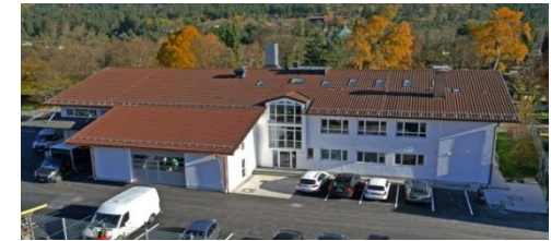
Werk III Garmisch-Partenkirchen
